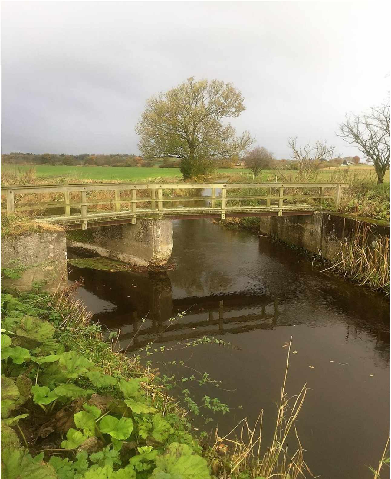
Fordelerbygværket hvor 1/3 af Susåens vand ledes ind i Torpe Kanal.
