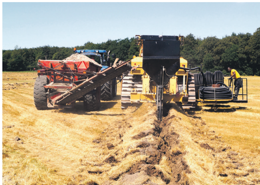
På grund af EU-krav er vandløbsregulativene tilpasset med det resultat, at vandløbenes vandafledningsevne er blevet reduceret i en periode, hvor klimaændringen har øget behovet for vandafledning. Det bør ændres, mener skribenten. Foto: Henrik Sieben
